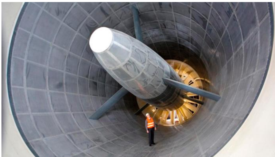
Der Windkanal während der Bauphase: Abstromkörper des Gebläses
